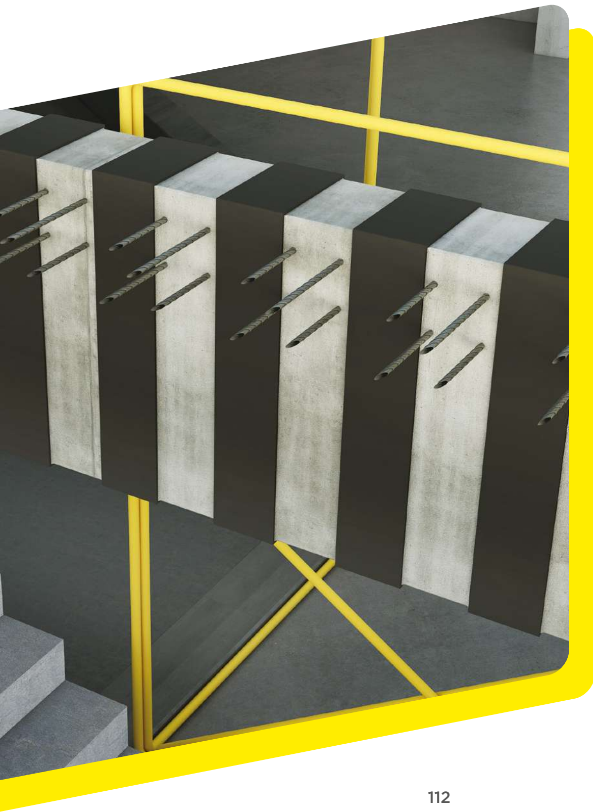
1 Lixamento do substrato
